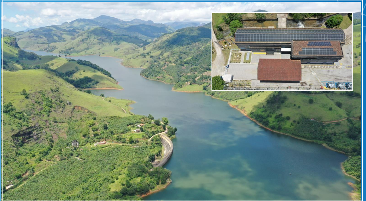
Complexo Hídrico-Solar Macabu
